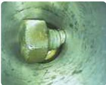
Schraube in einer Rohrleitung
