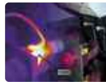
Anzeigeleuchte hinter Gehäuse
