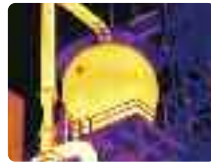
Industrielle Thermografie: Behälter
