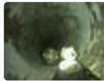
Fremdteilebergung mit Magnet-Bergewerkzeug
