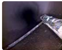
Fremdkörperbergung aus einem Rohr durch GR 16
