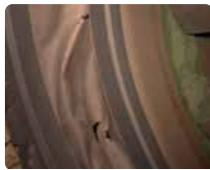
Entrauchungsschacht: Manschette defekt
